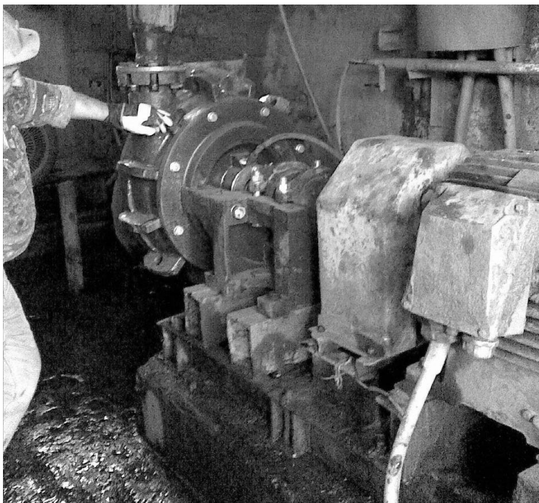
Rys. 9. Pompa na stanowisku w KWK „Sośnica”.
