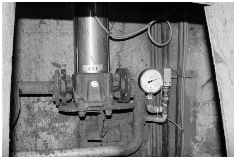
Rys. 10. Układ przygotowania wody dławnicowej.
