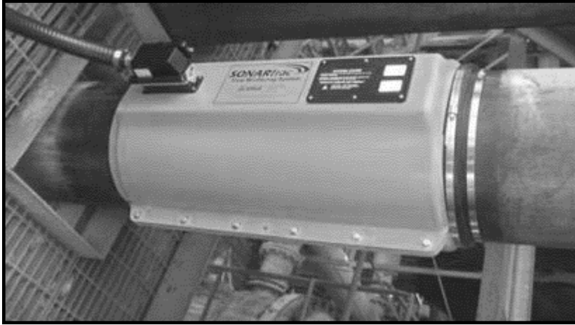
Rysunek 4. SONARtrack® zamontowany na instalacji.
