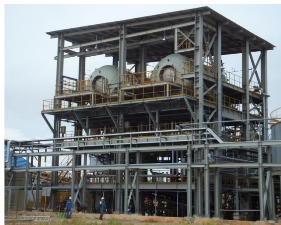
Zdjęcie 1: Filtry tarczowe HiBar (70 m 2 każdy) z kabinami parowymi do filtracji parowo-ciśnieniowej (po lewej); budynek filtrów z dwoma filtrami tarczowymi HiBar o pow. 70 m 2 każdy (po prawej)
