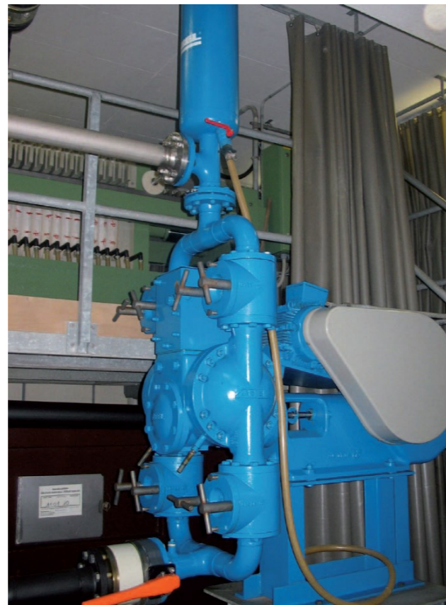
Zawory kulowe z otworem inspekcyjnym oraz czujnikiem przecieku membrany
