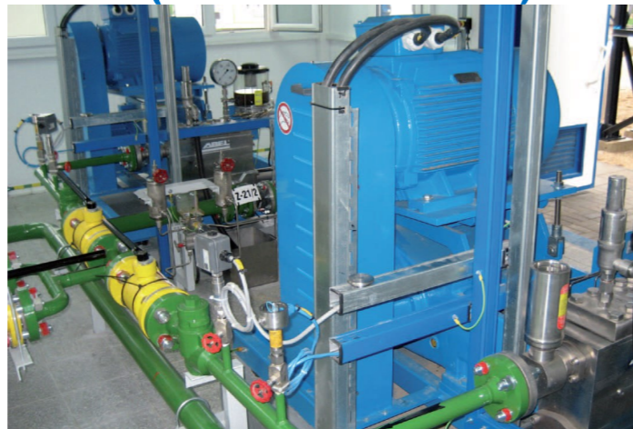
ABEL HPT do załaczania zaolejonej solanki przy ekstrakcji gazu
