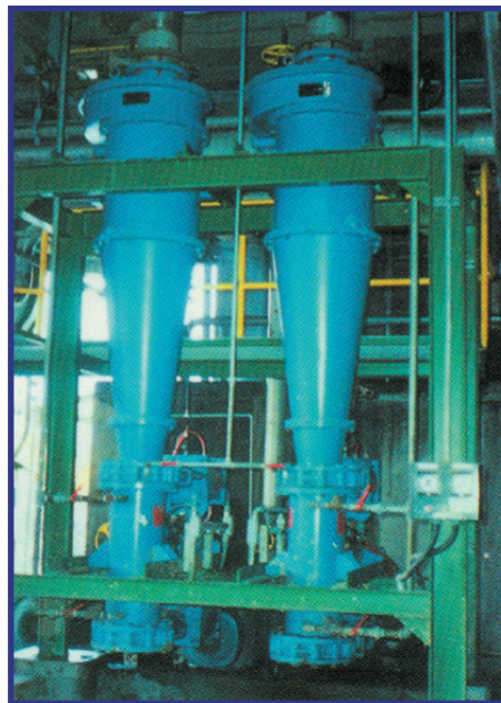
Oczyszczacze firmy KREBS usuwają zanieczyszczenia z miazgi papierowej
