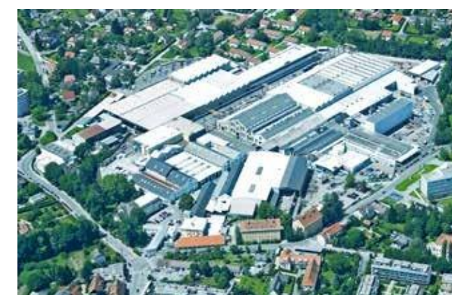
Zdjęcie lotnicze centrali i zakładu produkcyjnego ANDRITZ w Grazu
